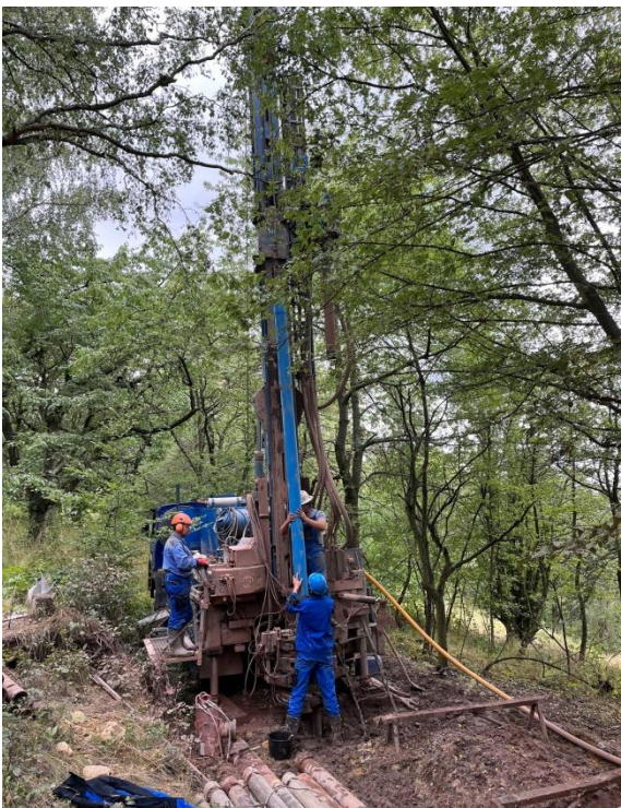
Vrtná souprava provádí odvrtání do hloubky 80 m, bylo prováděno dvěma dodavateli
