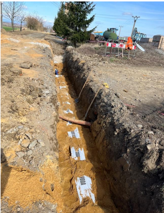
Pokládka vodovodního potrubí do otevřeného výkopu potrubí zapískované s položenou výstražnou fólií zemní práce pro výkopovou rýhu
