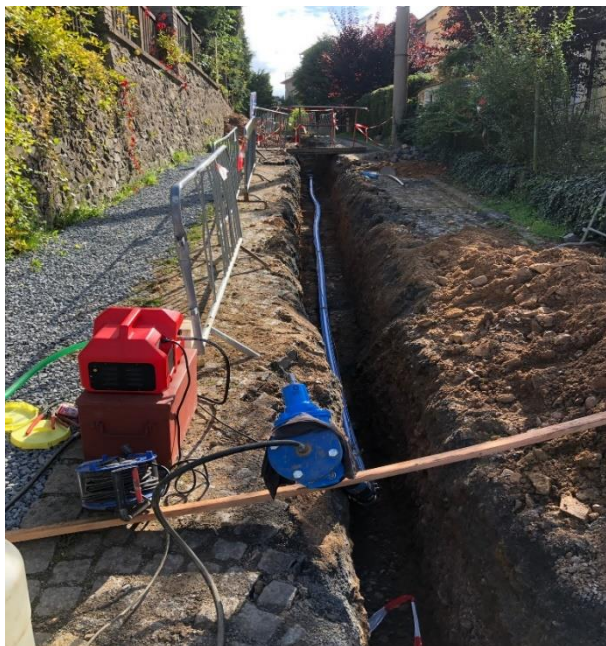
Uložení vodovodního řadu
