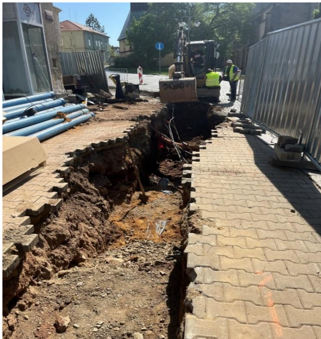
Rozebrání krytu chodníku za účelem výkopu
