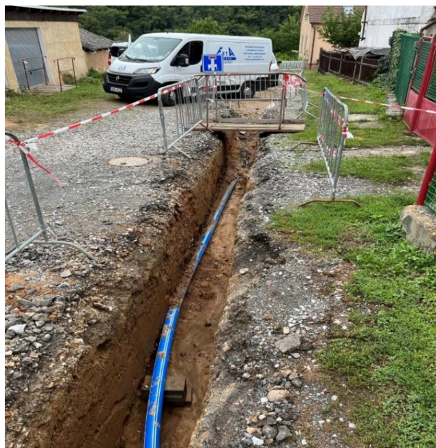
Uložení vodovodního řadu s pochozí lávkou
