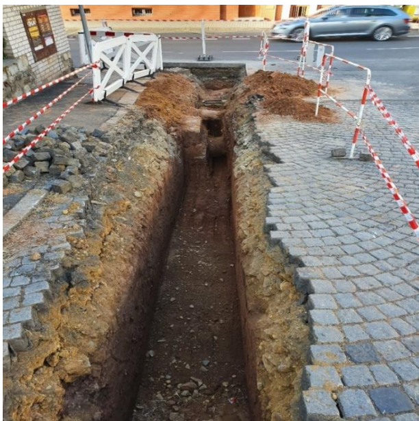
Rozebrání základny komunikace ze žulových kostek
