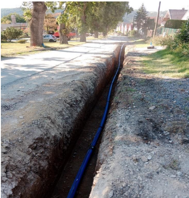
Uložení potrubí do rýhy
