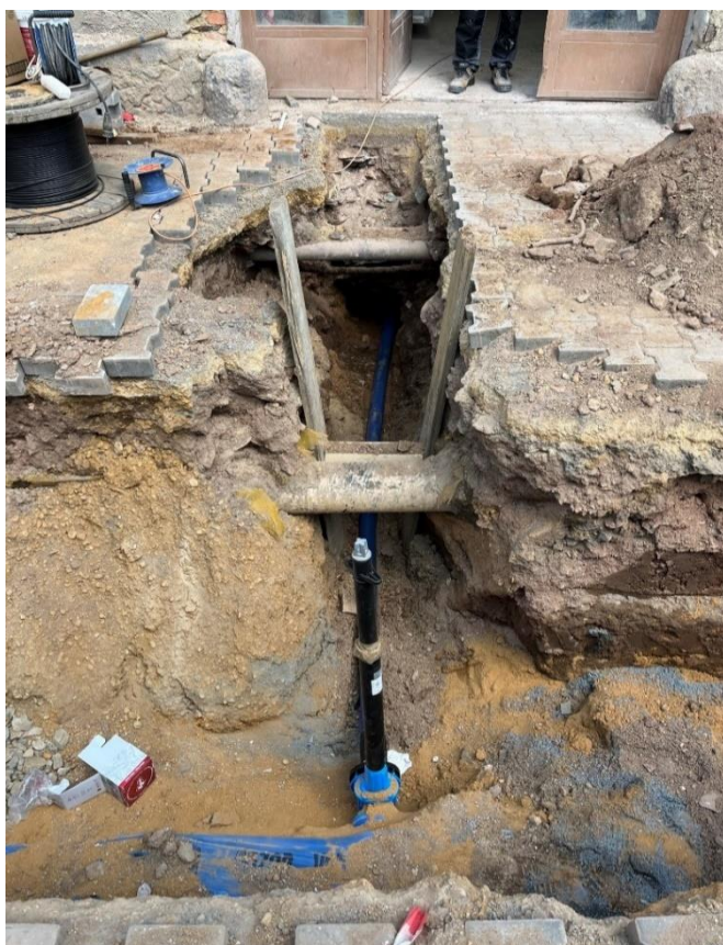
Obnova vodovodní přípojky
