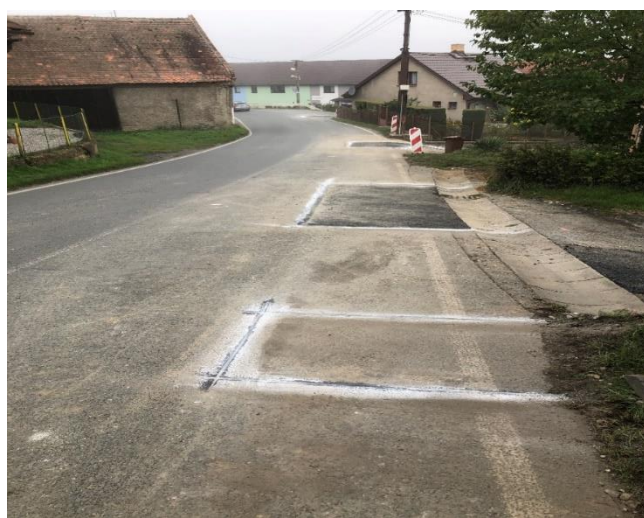
Vrchní asfaltová vrstva při začištění výkopové jámy
