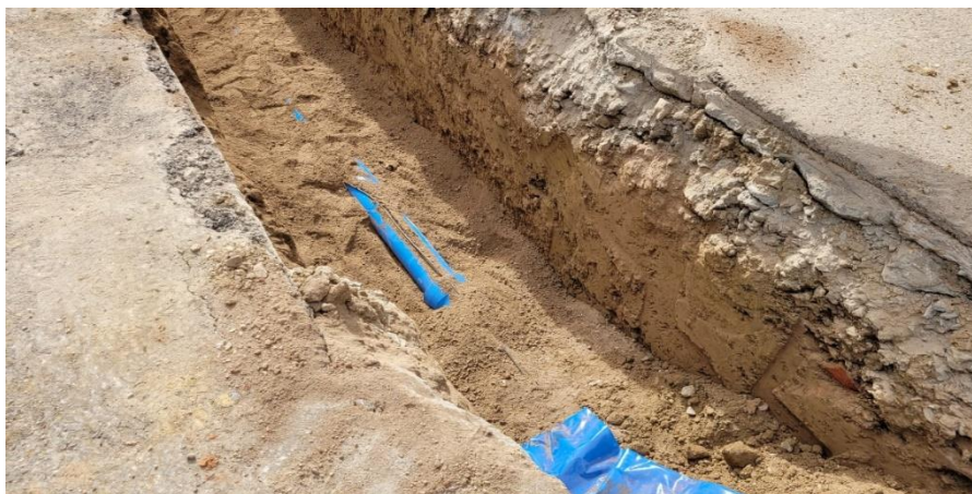
Položení výstražné folie a zásyp litinového potrubí pískem
