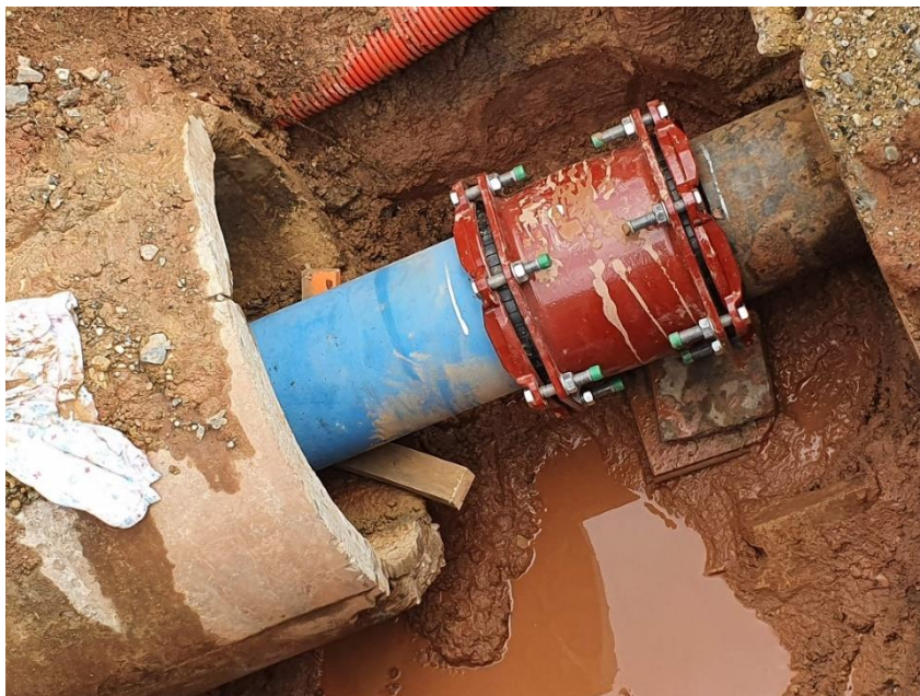
Spoj původního a obnovovaného vodovodu spojkou s úhlovým vychýlením
