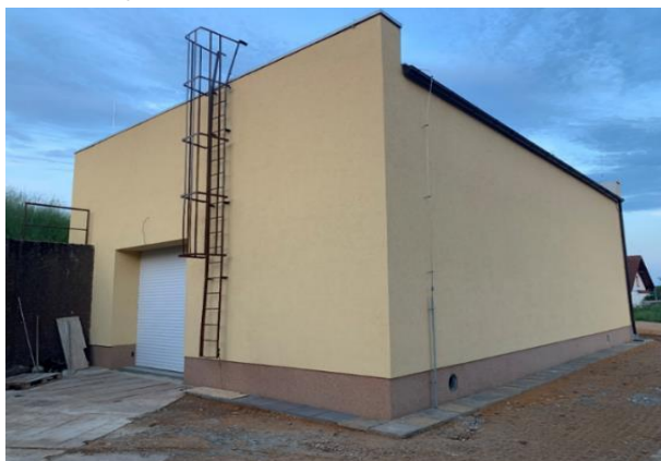
Budova ÚV – nová zateplená fasáda – bez instalace zařízení odhlučnění
