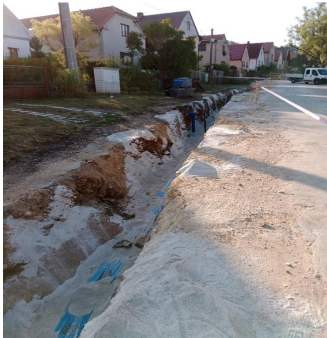
Zásyp obnovovaného vodovodního řadu
