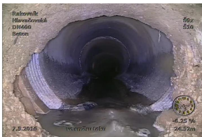
Materiálový přechod z kameninového do betonového potrubí
