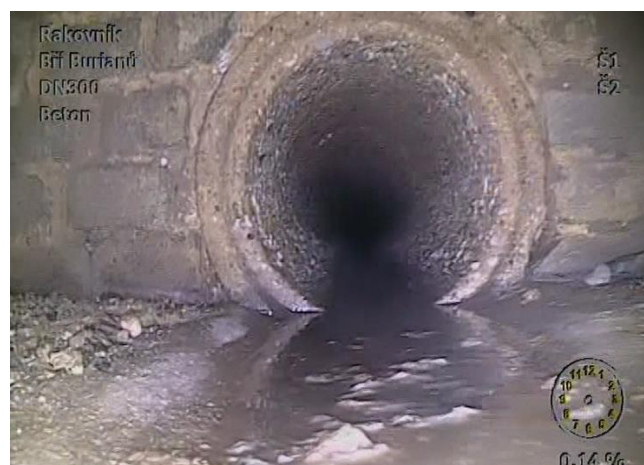
Pohled do stokového potrubí
