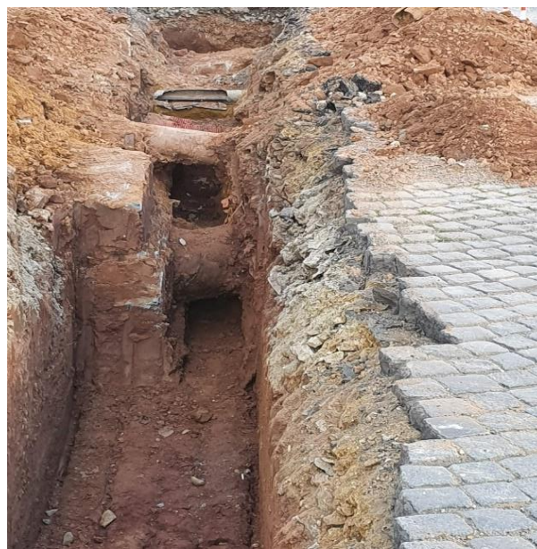
Rozebrání základny komunikace ze žulových kostek
