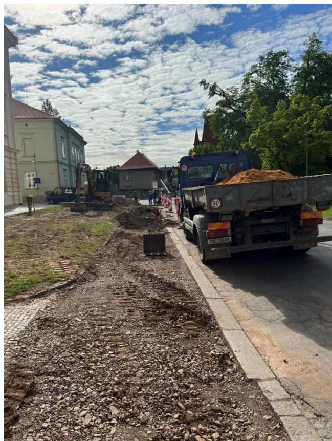
Provizorní zásyp výkopu
