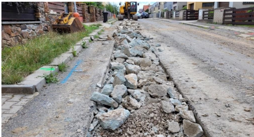
Rozebrání povrchu vozovky pikováním
