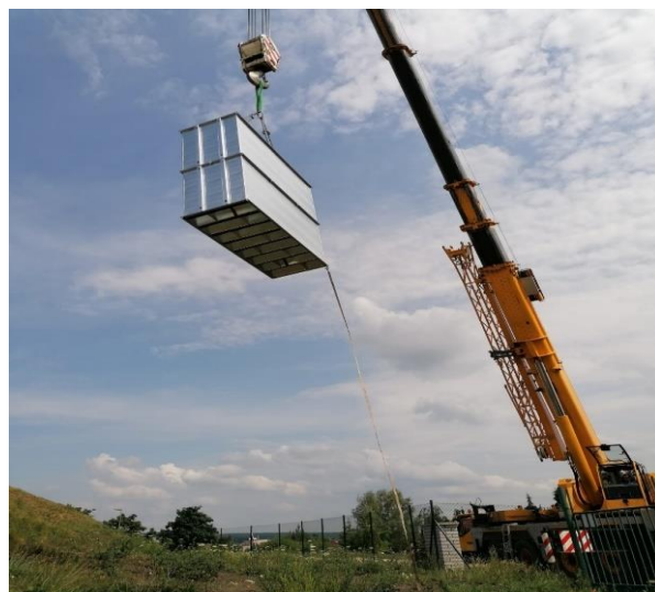
Přesun hlukového filtru pomocí jeřábu
