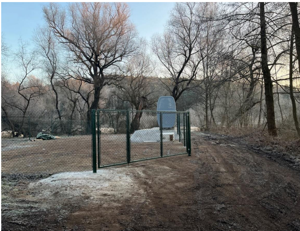
Sanace vrtu R4 – dokončení stavby včetně oplocení a instalace LBM buňky
