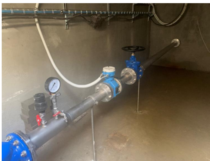
Vystrojení šachty vrtu R4
