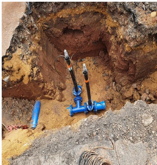
Usazení šoupatové armatury
