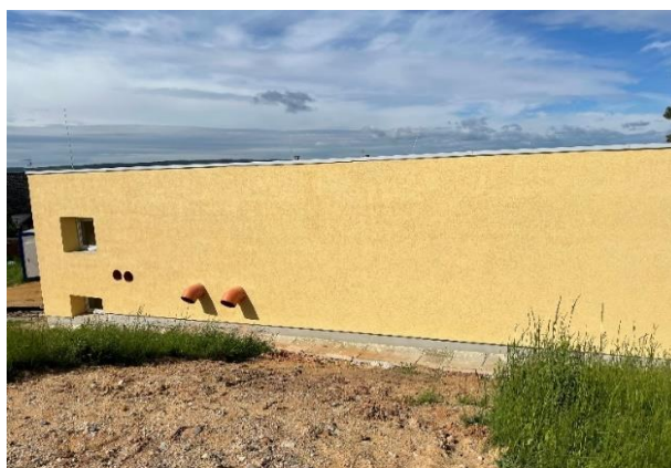
Budova ÚV – nová zateplená fasáda – bez instalace zařízení odhlučnění
