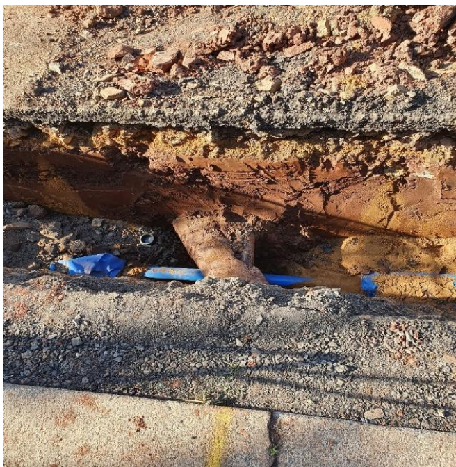
Křížení vodovodního potrubí s kanalizační přípojkou
