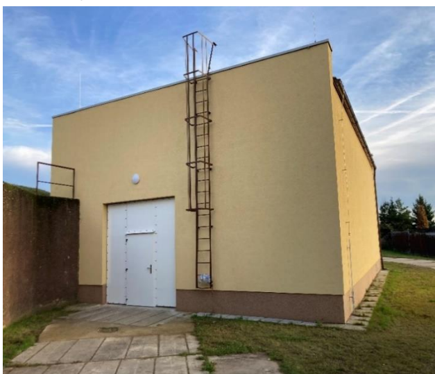
Budova ÚV – nová protihluková úprava vstupu
