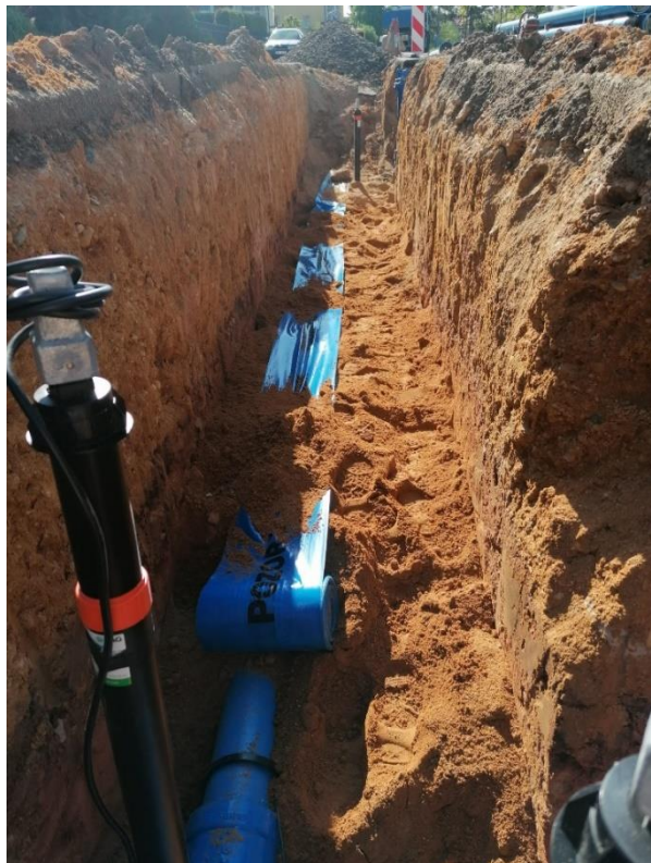
Výstražná folie a zásyp potrubí pískem
