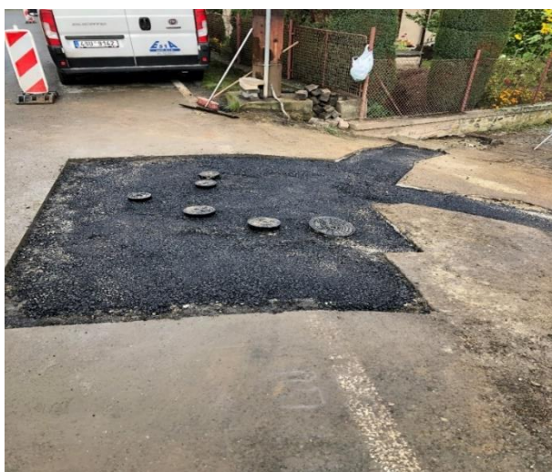
Spodní asfaltová vrstva při začištění výkopové jámy
