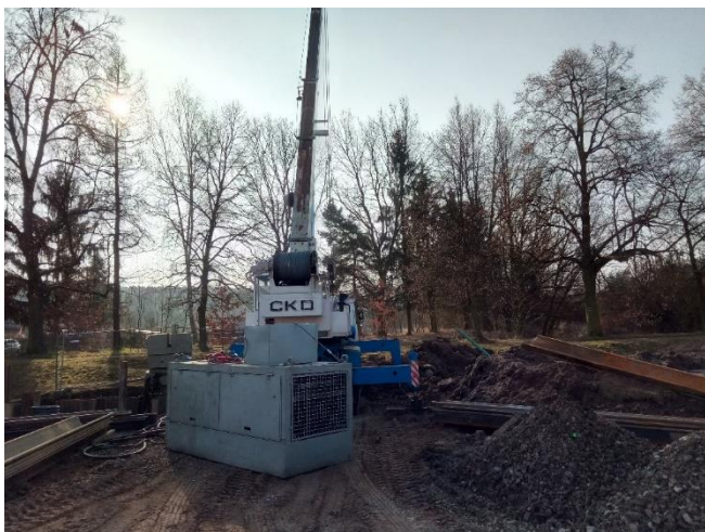
Mechanizace pro instalaci stěny ze štětovic
