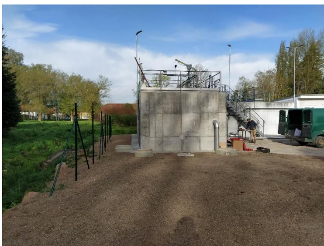
Přístavba dosazovací nádrže
