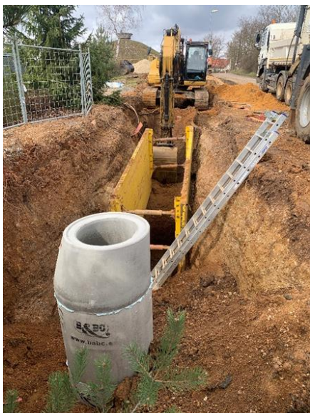
Pokládka stokového potrubí včetně RŠ
