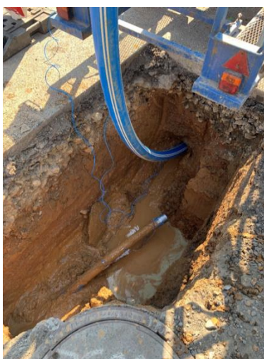
Pokládka potrubí metodou řízeného podtlaku
