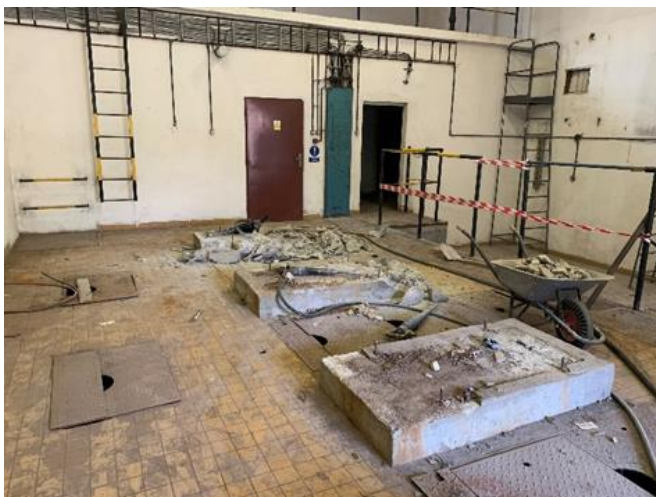
Prostor budovy po demontáži původní technologie ATS
