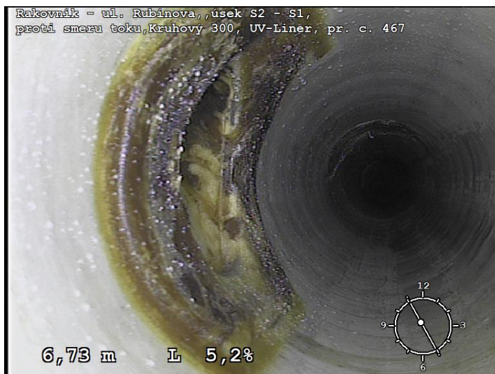
Zapravení napojení přípojky a stokového potrubí
