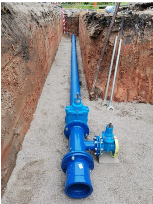
Uložení vodovodního řadu a montáž armaturního uzlu
