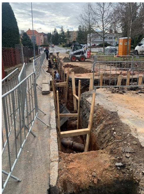
Pažení výkopové rýhy
