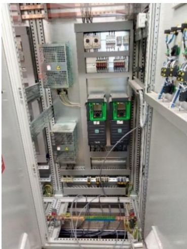
Elektroinstalace rozvaděče
