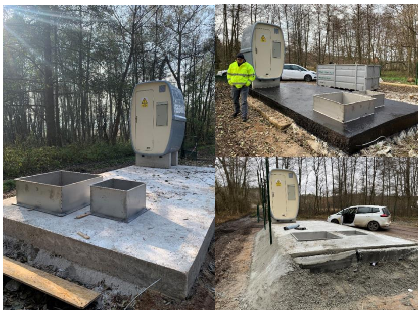
Sanace vrtu R4 – dokončení stavby
