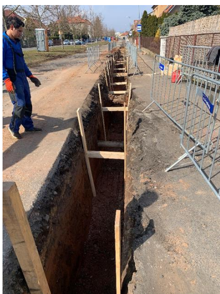
Pažení výkopové rýhy
