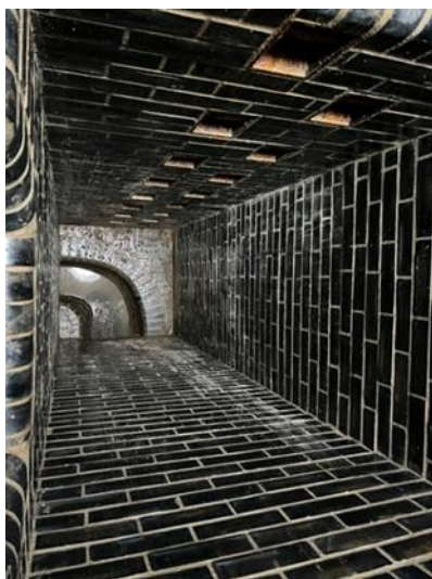
Spojné a spadiškové objekty – vyzdívka včetně čedičových prvků
