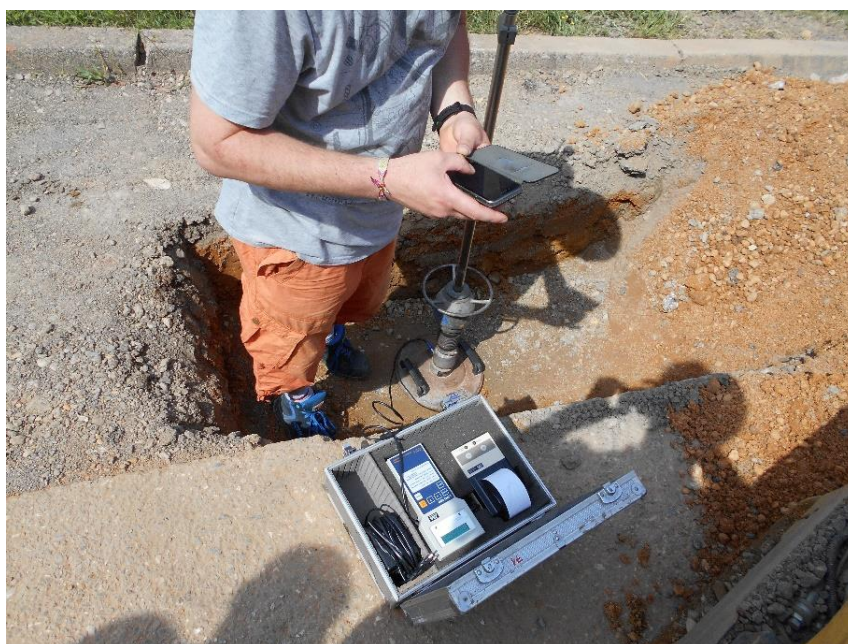
Hutnící zkouška na úrovni zásypových vrstev
