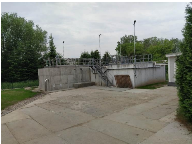
Pohled na dokončenou intenzifikaci – přístavba nádrží vlevo
