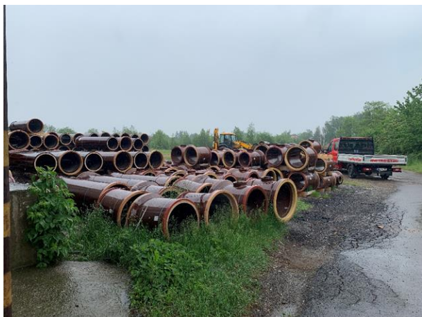
Závoz materiálu na stavbu – kameninové a PE - potrubí
