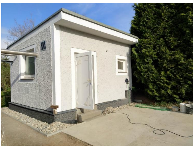
Provozní domek ČOV se sanací soklové konstrukce
