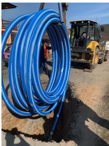
Pokládka potrubí metodou řízeného podtlaku
