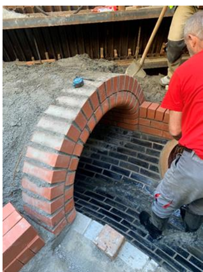
Spojné a spadiškové objekty – vyzdívka včetně čedičových prvků
