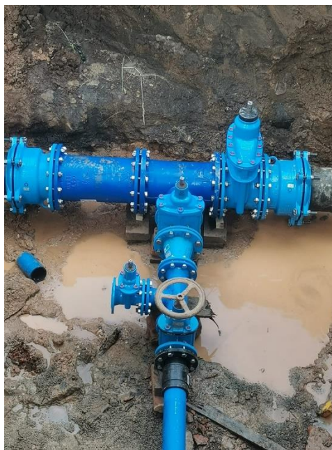
Napojení nové vodovodní přípojky s předřazeným vodovodním šoupětem
