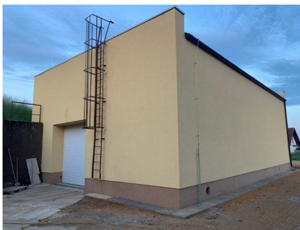
Budova ÚV – nová zateplená fasáda
