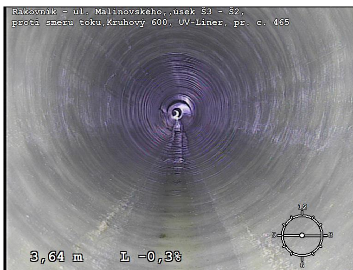
Pohled do stokového potrubí s nainstalovaným sklolaminátovým rukávem
