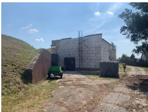
Budova ÚV – stav bez původní fasády
