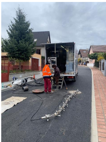
Instalace vytvrzovací UV – lampy
