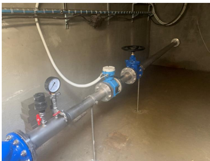
Vystrojení šachty vrtu R4
