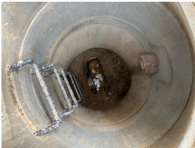
- sanované šachty včetně začištění stávajících prostupů pomocí sanační rychle tuhnoucí směsi Ergelit
