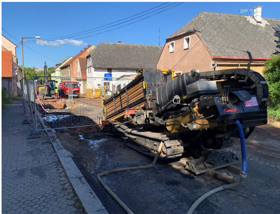
- provádění pilotního vrtu
