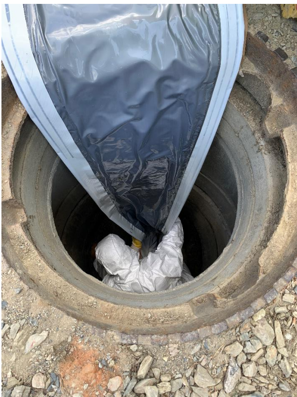
- zatahování sklolaminátového rukávce do kanalizační stoky pro bezvýkopovou sanaci v úseku od šachty po následující šachtu
