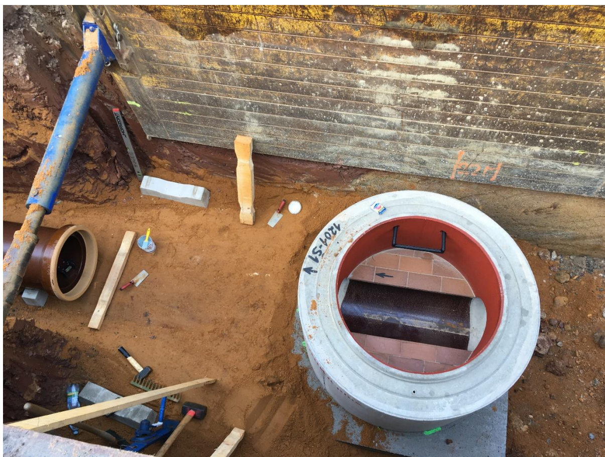
- osazení kontrolních šachet s kameninovou kynetou a čedičovým obkladem na úrovni dna
