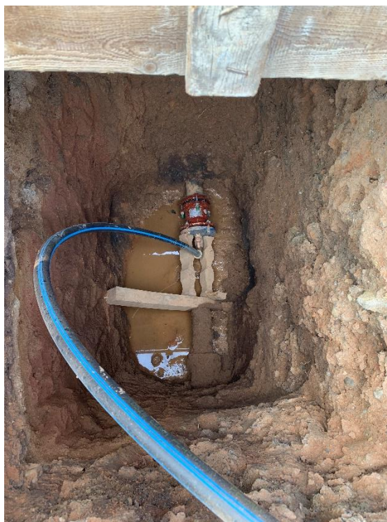
- napojení provizorního vodovodního potrubí
