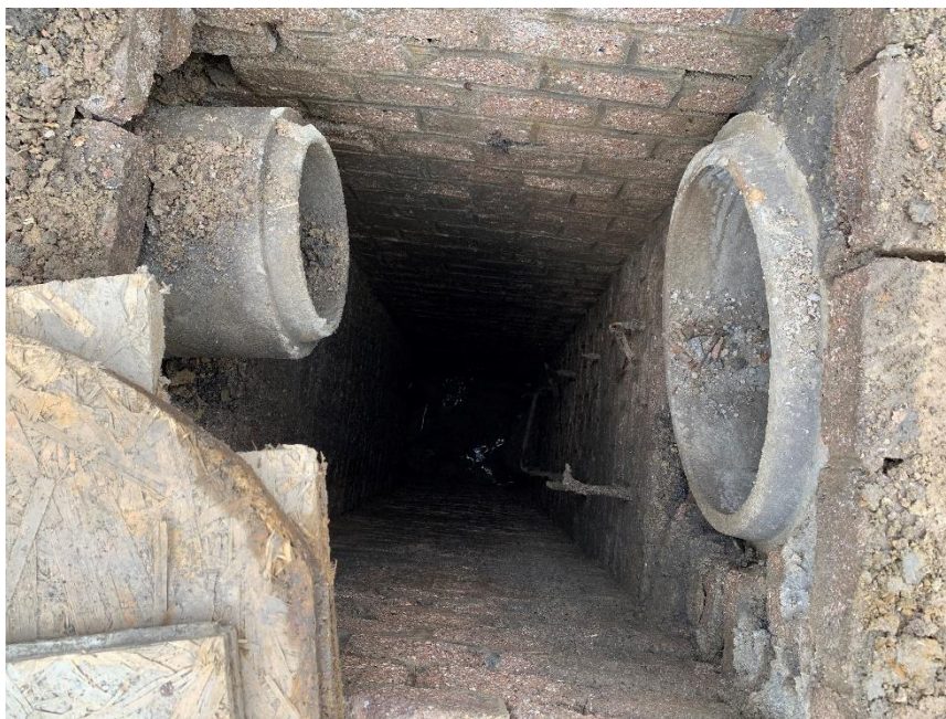
- stávající revizní kanalizační šachta
