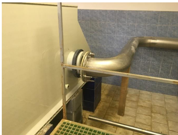
- napojení na stávající rozvody
