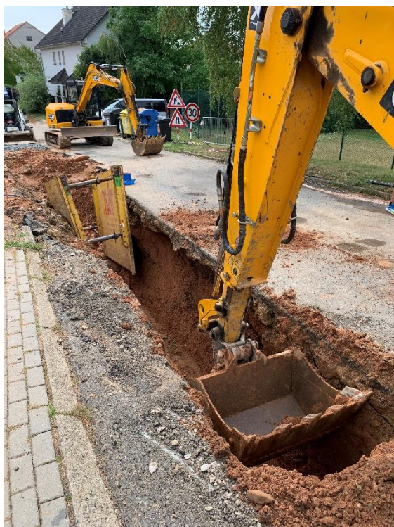
- otevřený výkop pro obnovu vodovodu novým litinovým potrubím
