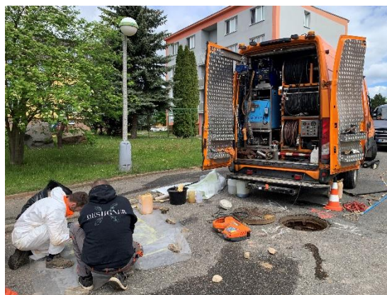
- příprava krátké sklolaminátové vložky před instalací do stoky (sanace krátkých úseků stok)
