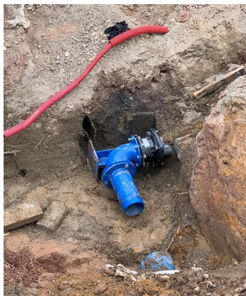
- napojení na stávající již obnovený vodovodní řad pomocí zakusovací armatury SYNOFLEX
