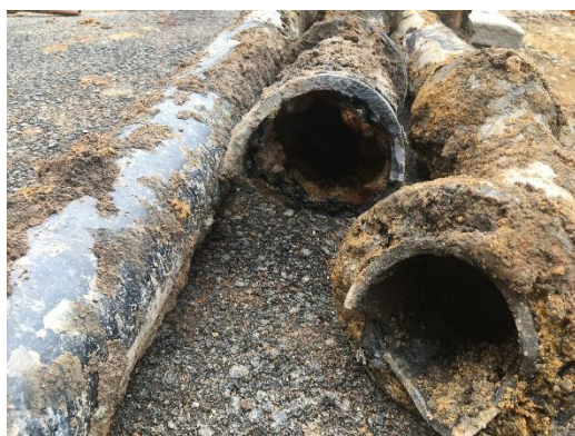
- původní demontované potrubí
