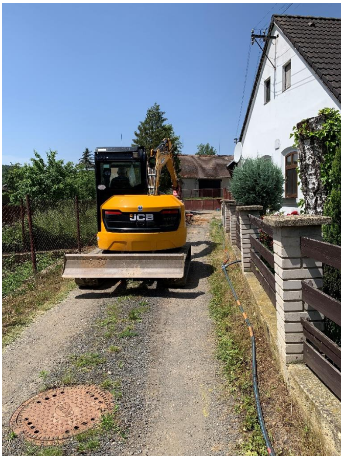
- výkopové práce prováděné v úzké uličce ve stávající zástavbě pomocí otočného bagru
