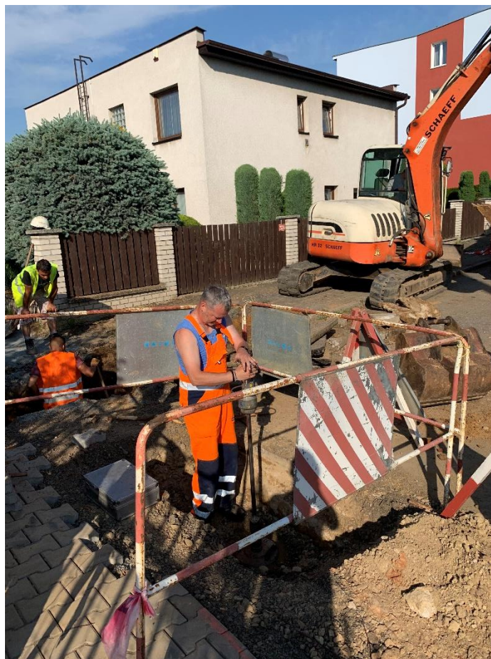
- hutní zkouška zemní plně po provedení obnovy
