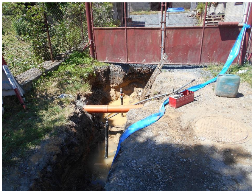
- tlaková zkouška nového vodovodního řadu
