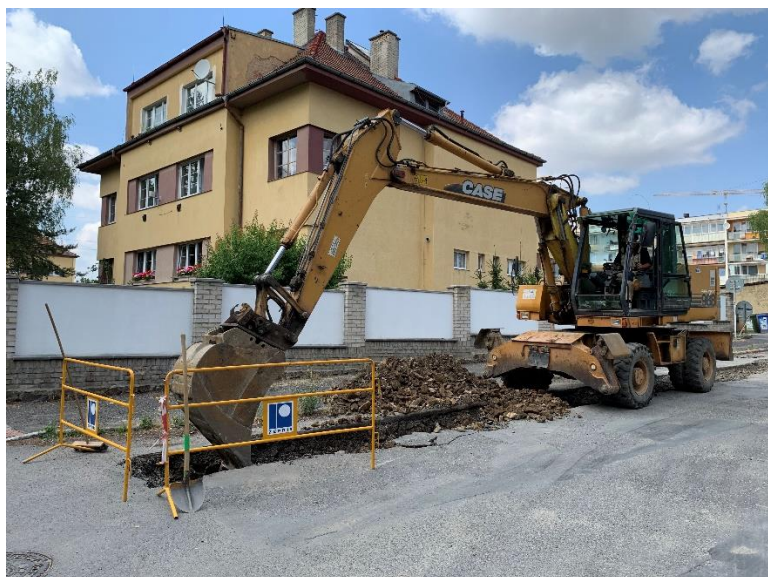
- výkopové práce na obnově vodovodu
