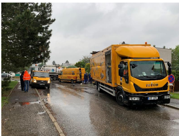
- příjezd techniky pro instalaci dlouhých sklolaminátových rukávců - bezvýchopová technologie sanace potrubí
