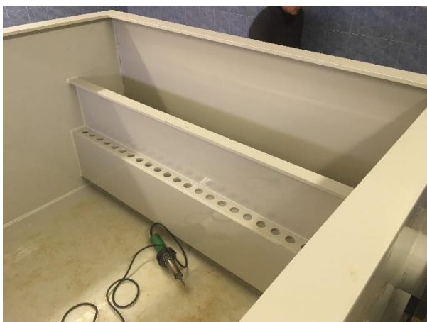
- svaření nové nádrže přímo v místě instalace
