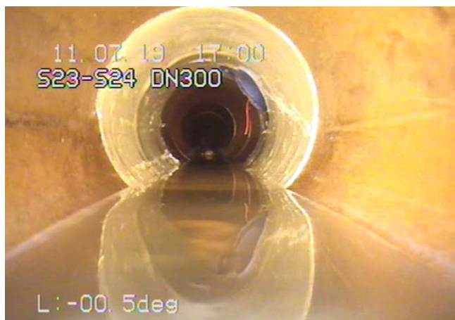
- již osazená krátká sklolaminotová vložka včetně otevření a zapravení stávající kanalizační přípojky pomocí injektážního robota
