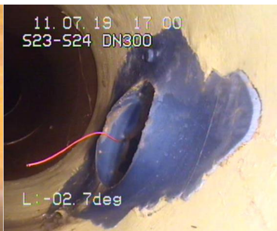
- již osazená krátká sklolaminotová vložka včetně otevření a zapravení stávající kanalizační přípojky pomocí injektážního robota
