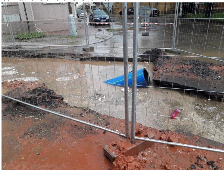
- zatahování nového potrubí do předvrtaného a rozšířeného vrtu
