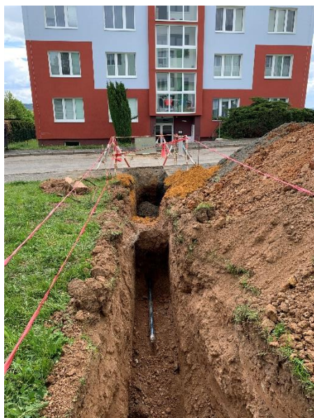
- obnova přípojky pro panelový dům
