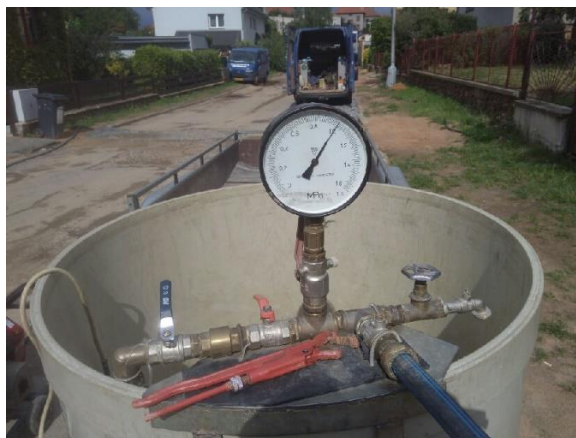
- tlaková zkouška vodovodního potrubí po provedení obnovy
