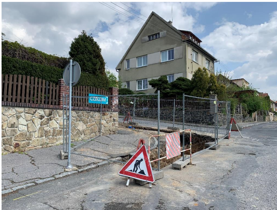
- výkopové práce u penzionu Bezděkov na rohu ulice Vinohradská a Soukupova
