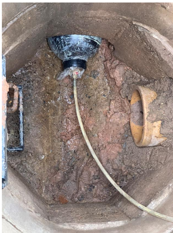
- umístění krátké sklolaminátové vložky do stoky pomocí robota a nafukovacího válce
