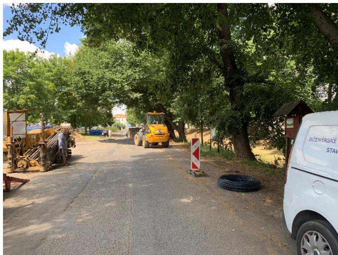
- příjezd vrtné techniky na provedení řízeného podvrtní
