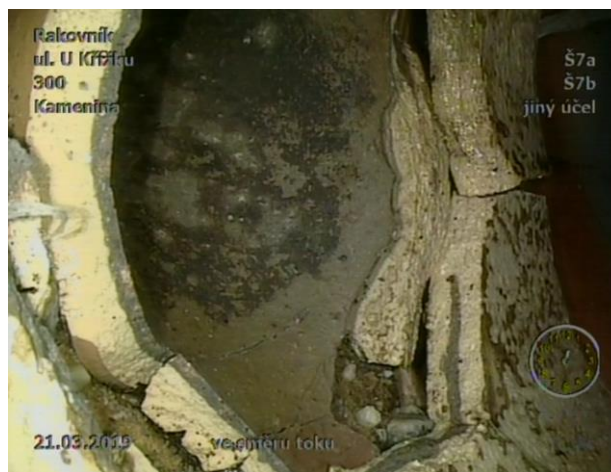
- neodborné napojení kanalizační přípojky do stoky
