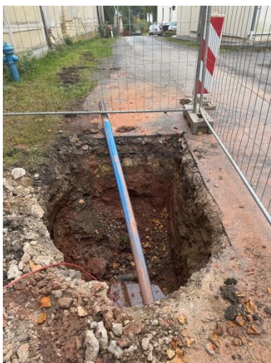
Jáma pro provedení bezvýkopového zatažení potrubí PE
