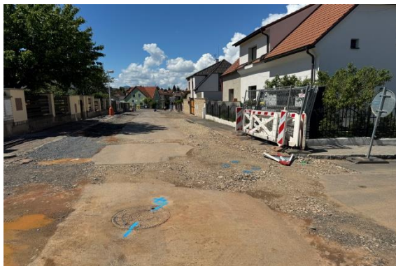
Ukončení pokládky vodovodu, povrchy ulice řeší ve spolupráci Město Rakovník, děkujeme
