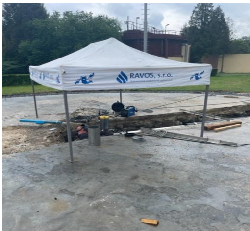
Provedená sanace základové desky plynojemu a příprava pro napojovací potrubí
