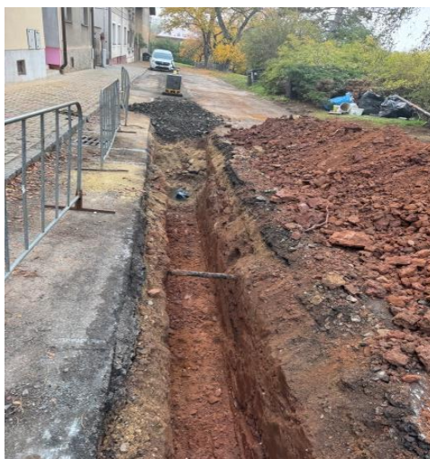
Pokládka vodovodu do výkopové jámy povrchy ulic řešíme ve spolupráci s Městem Rakovník, děkujeme.
