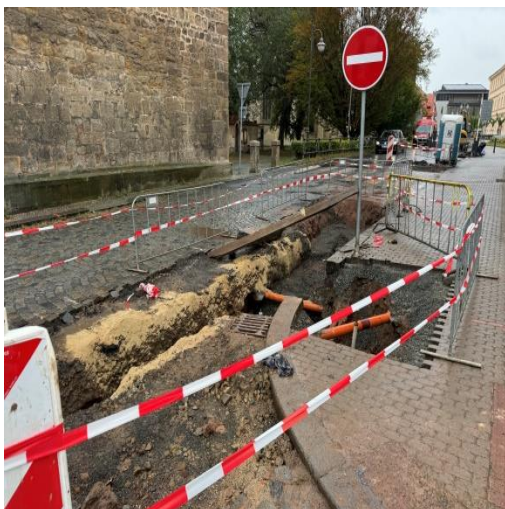
Pokládka vodovodu do výkopové jámy povrchy ulic řešíme ve spolupráci s Městem Rakovník, děkujeme.
