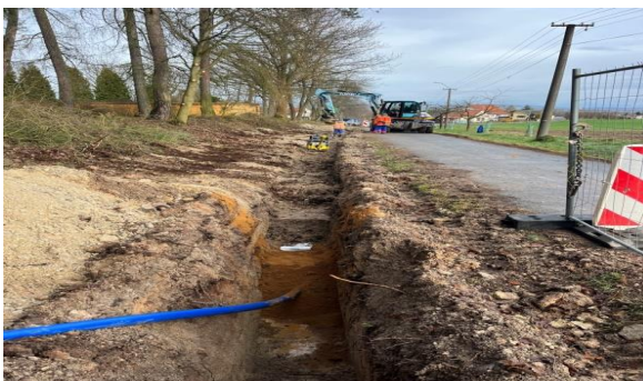
Pokládka PE potrubí do otevřeného výkopu
