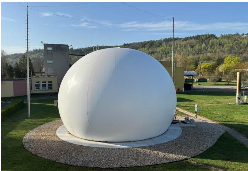
Dokončený nový plynojem (foto: Luboš Týče)
