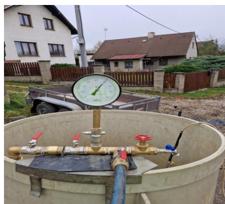
Provedení tlakové zkoušky potrubí
