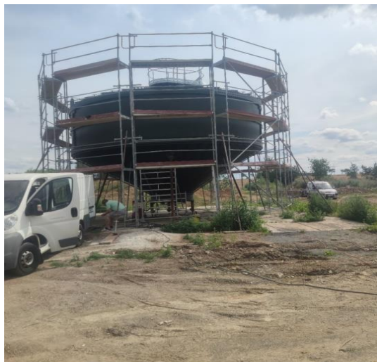
Akumulační komora s lešením pro další opláštění
