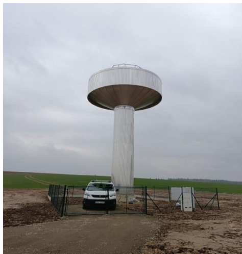
Dokončený věžový vodojem Hvozd 100 m3
