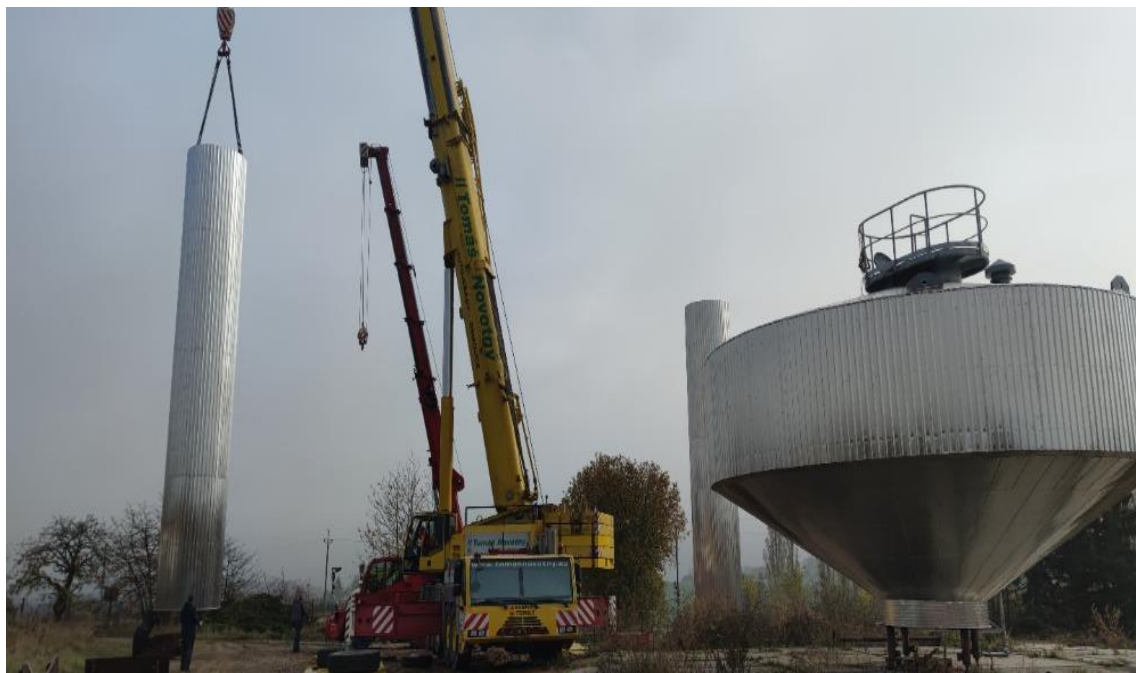
Montáž dvou částí dříku a akumulční komory vodojemu jeřábem
