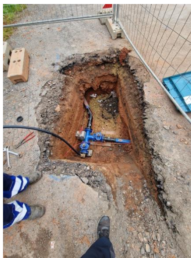
Šoupatový uzel na křížení dvou řadů
