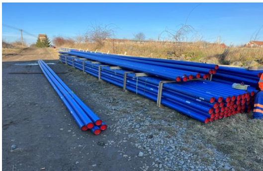
Skládka vodovodního potrubí PE
