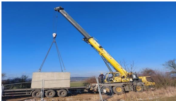
Vykládka ŽB-šachty pro měření a regulaci spotřebiště obce
