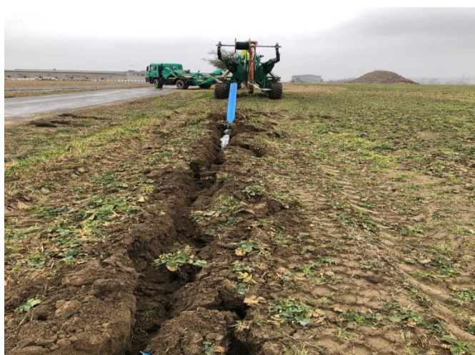
Pokládka vodovodního potrubí technologií pluhování
