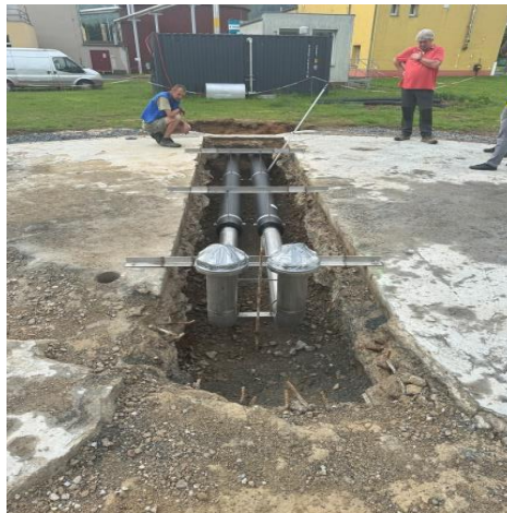
Instalované napojovací potrubí do komory
