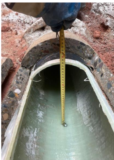
Vyříznutá horní část sklolaminátového rukávce
