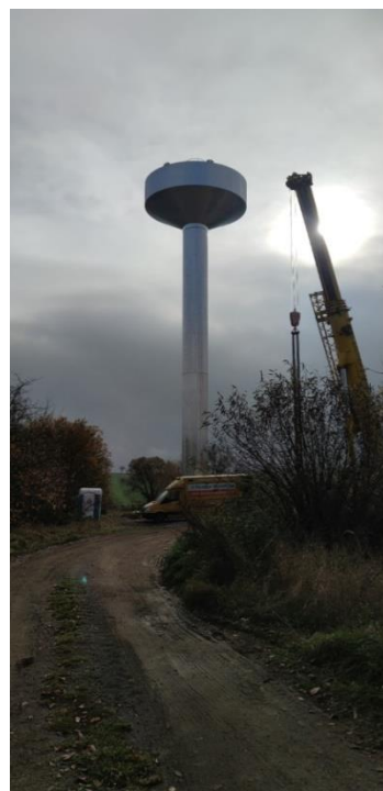
Dokončená montáž vodojemu
