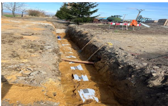
Pokládka PE potrubí do otevřeného výkopu, zásyp a výstražná fólie
