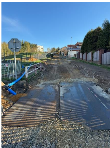
Pohled do ulice s provizorním nájezdem z ocelových desek
