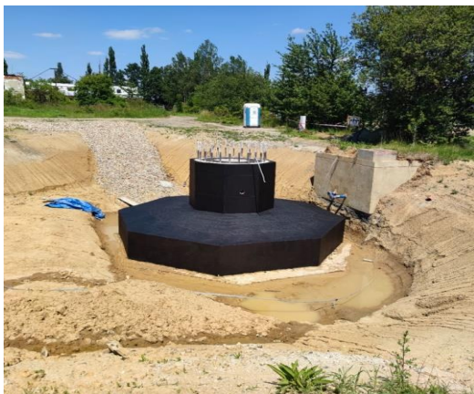
Základová patka vodojemu opatřená hydroizolačním nátěrem
