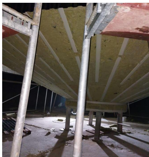
Instalace tepelné izolace na akumulční komoru
