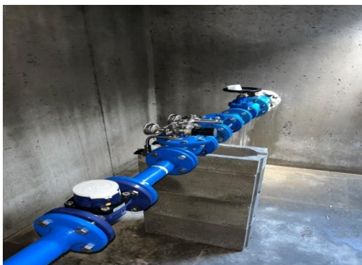
Instalace armatur v šachtě před spotřebišťem obce
