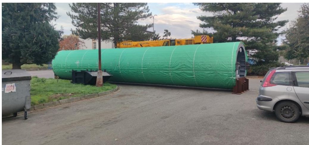
Ocelová část nohy vodojemu připravená v ochranném obalu pro transport z jižní Moravy do Panošího Újezdu
