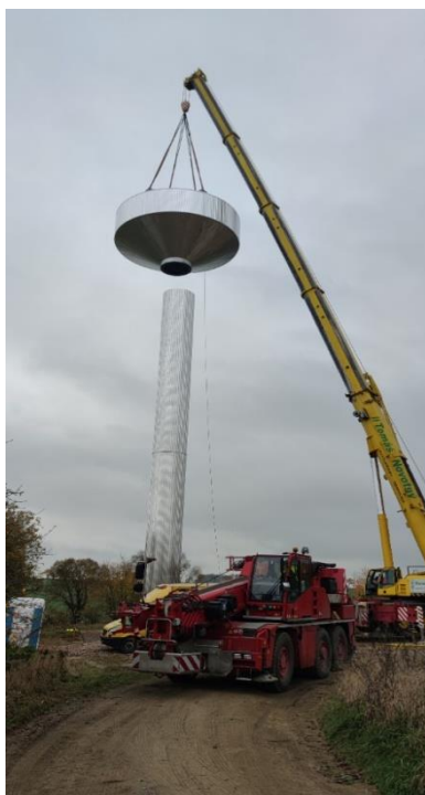
Montáž akumulční komory
