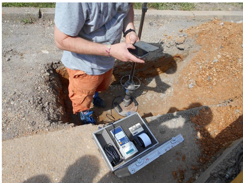
obr. 42.: Hutní zkouška na úrovni zásypových vrstev
