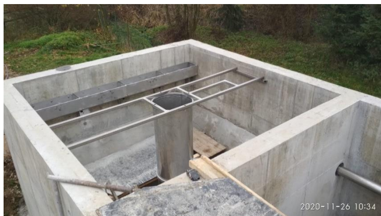
obr. 15.: Montáž nátokového válce
