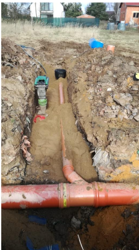
obr. 34.: Zapískování kan. přípojky a kan. řadu
