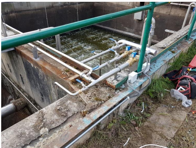
obr. 22.: Dokončený armaturní uzel
