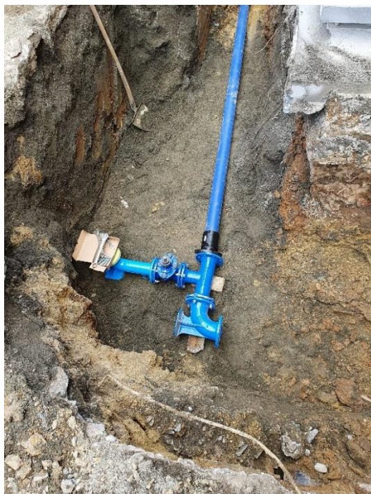
obr. 38.: Usazení armaturního uzle s montáží hydrantu a šoupěte
