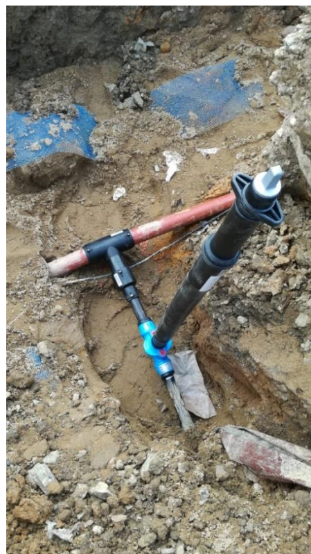
obr. 37.: Kanalizační přípojka řadu připojena na tlakovou kanalizaci
