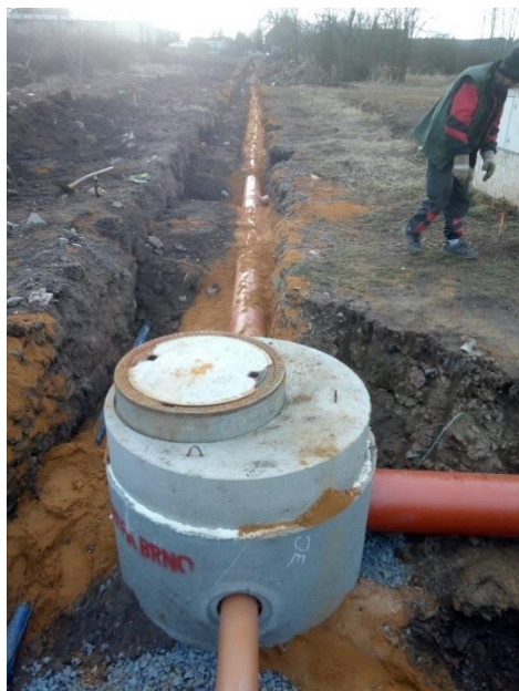
obr. 30.: Kanalizační šachta a zapískování kanalizačního potrubí
