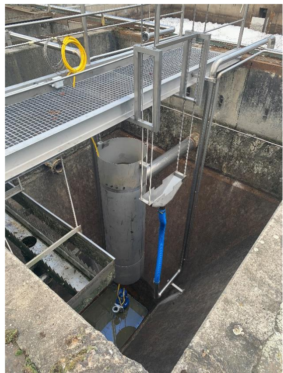
obr. 25.: Zavěšení žlabu odtahu plovoucích nečistot na úroveň budoucí vodní hladiny
