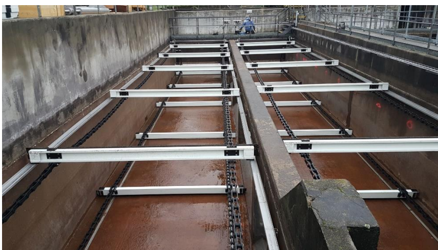
obr. 8.: Horní a dolní kluzné lišty, shrabovací lopatky
