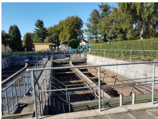
obr. 1.: Původní poruchové shrabovací linky
