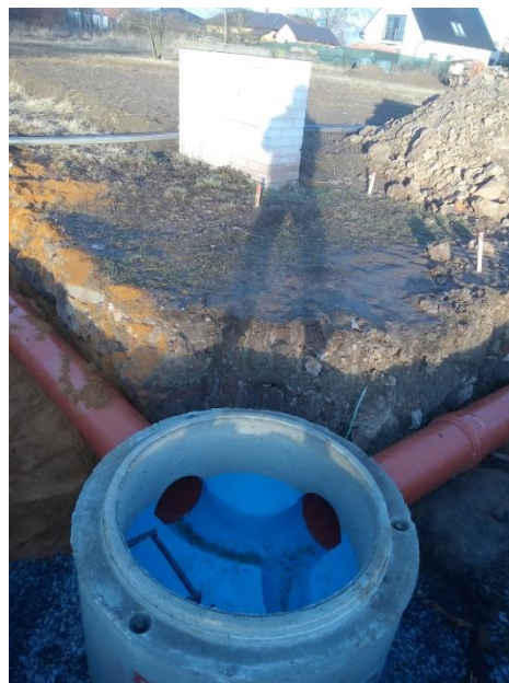
obr. 31.: Dno kanalizační šachty
