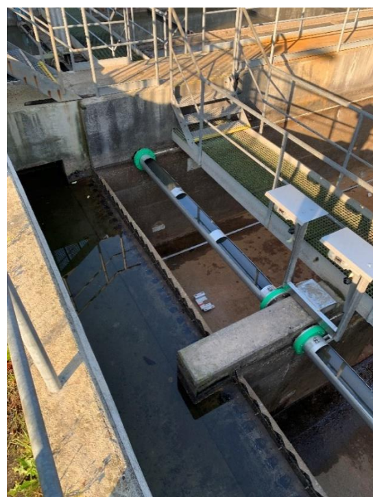
obr. 5.: Nový naklápěcí žlab s el. motorem
