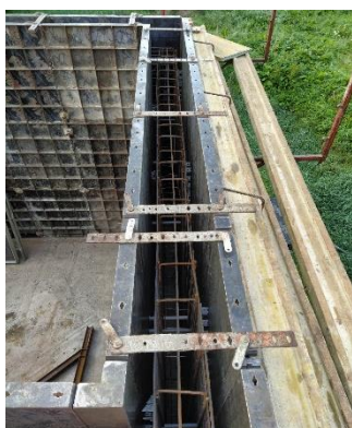
obr. 12.: Svislá stěnová výztuž
