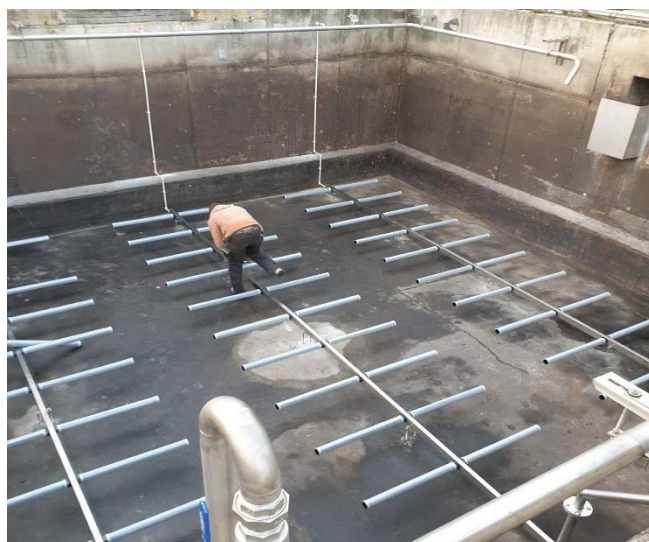
obr. 20.: Příprava pro montáž provzdušňovacích elementů
