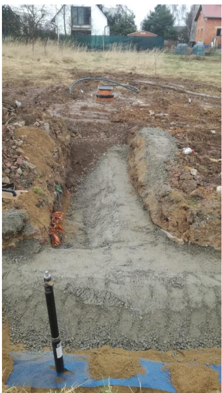
obr. 36.: Obetonování kan. přípojky a kan. řadu
