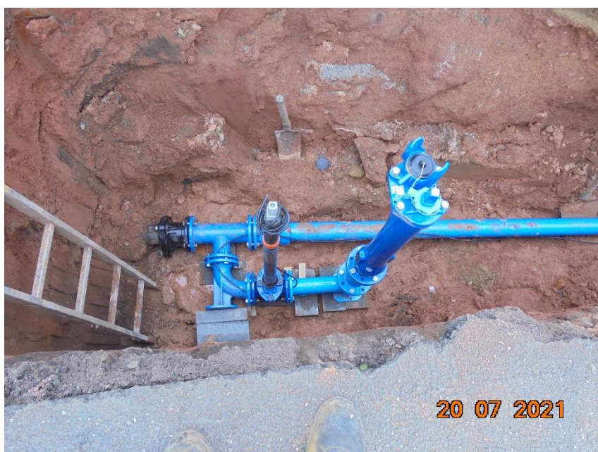
obr. 41.: Usazení hydrantu a šoupěte
