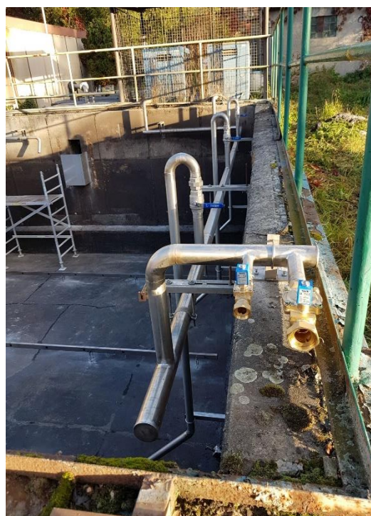
obr. 21.: Příprava armaturního uzle
