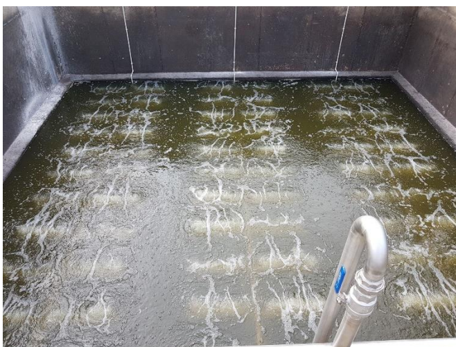
obr. 24.: Zkouška provzdušňovacích elementů
