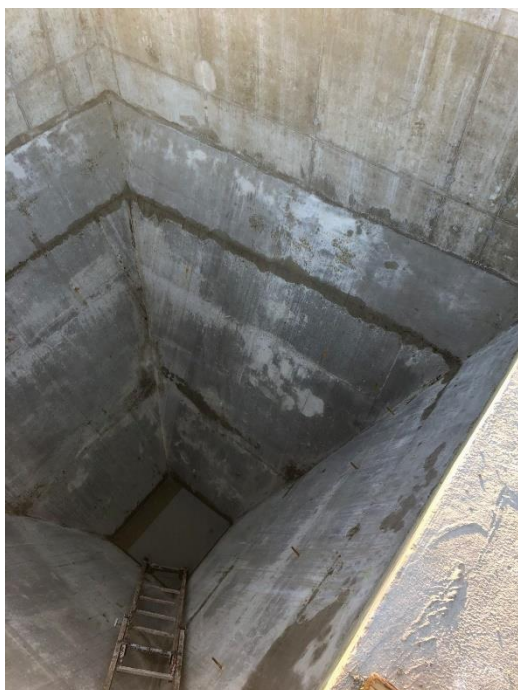
obr. 14.: Odbednění zkosené stěny dosazovací nádrže
