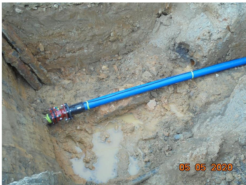
obr. 40.: Napojení na stávající řad
