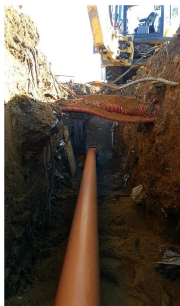
obr. 33.: Vedení kan. řadu výkopovou rýhou
