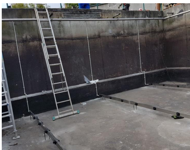
obr. 19.: Instalace potrubí pro rozvod vzduchu
