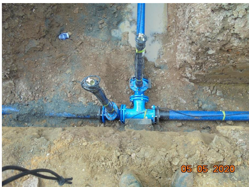
obr. 39.: Armatura (T-kus) spojující vodovodní řad
