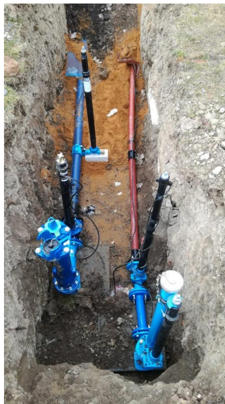
obr. 35.: Ukončení vodovodního a kanalizačního řadu
