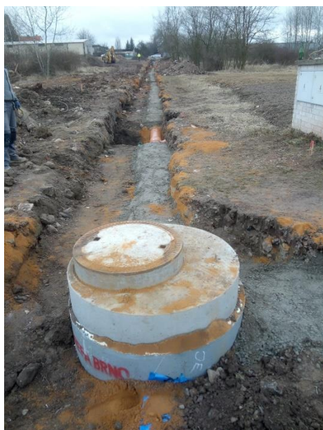
obr. 32.: Obetonování kan. řadu
