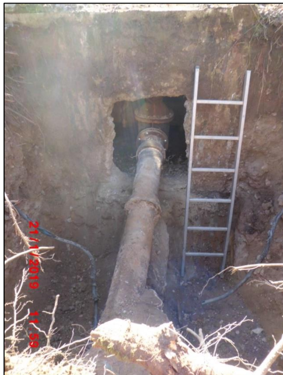
vytvoření prostoru pro demontáž
