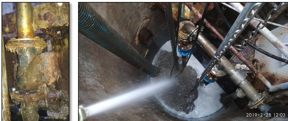
Obr. instalace nových zpětných klapek, zkouška čerpání
