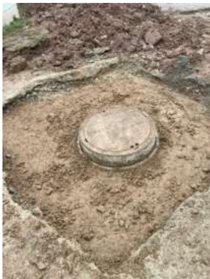
RAKOVNÍK, UL. KOUBKOVA – OPRAVA KANALIZAČNÍ ŠACHTY, VÝMĚNA VĚTŠINY ČÁSTÍ (KÓNUS, SKRUŽ, RÁM)
