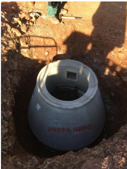
-obnova revizní šachty stoky
