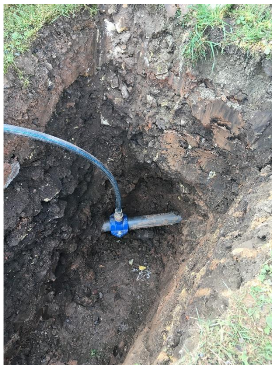
- připojení vodovodní přípojky do provizorního vodovodu
