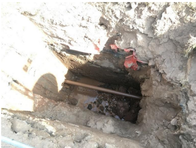
- průchod tyče podvrťové soupravy výkopovou sondou
