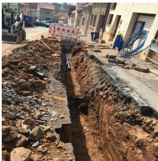
-otevřený výkop pro obnovu vodovodu novým litinovým potrubím
