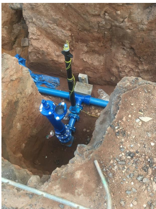
-instalace podzemního hydrantu
