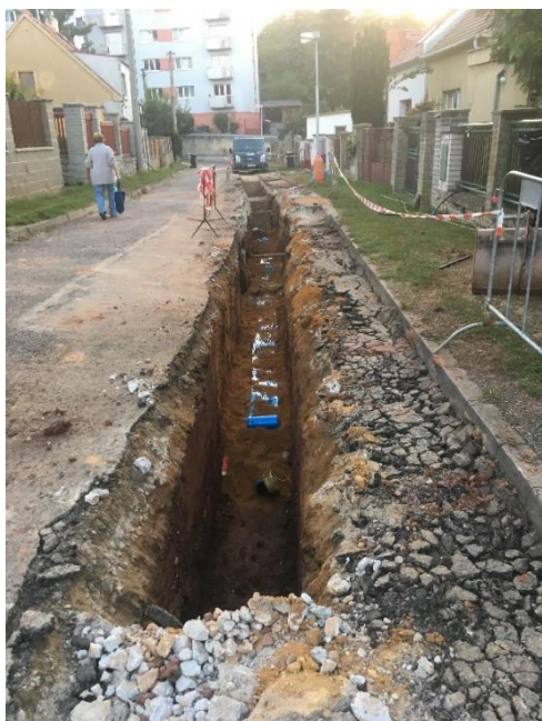
-zásyp výkopové rýhy s položením výstražné fólie
