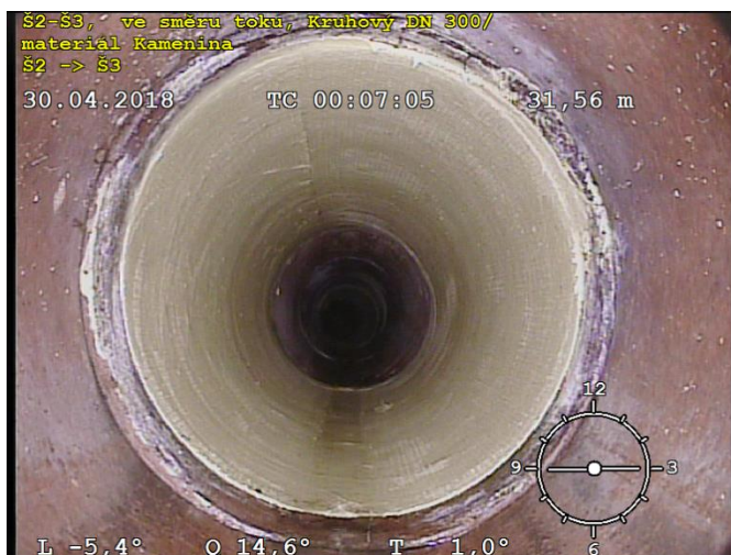
-provedení krátké sklolaminátové vložky na kameninovém potrubí DN 300, vložky instaloval robot pomocí nafukovacího vaku
