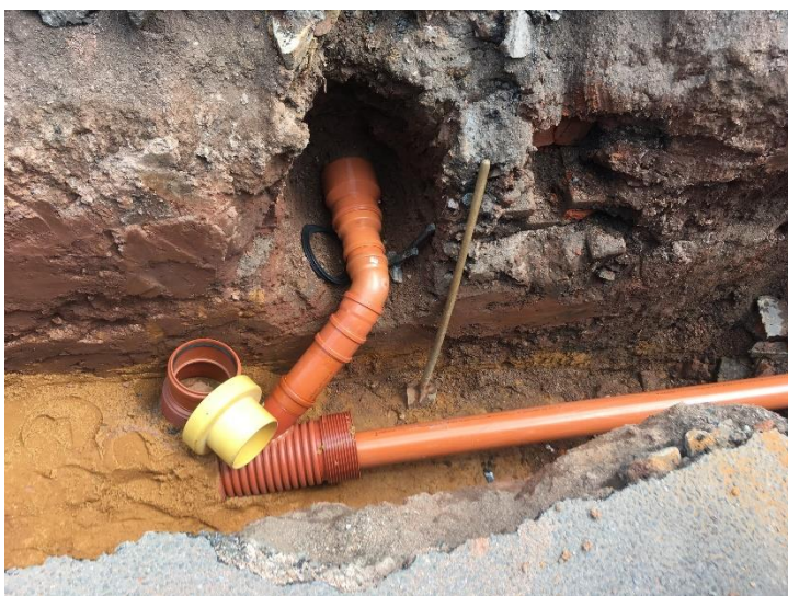
-provizorní napojení přípojného potrubí kanalizace
