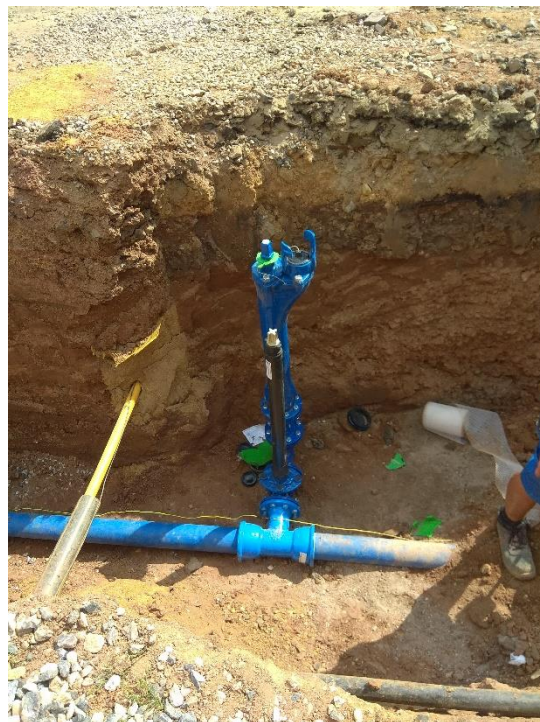
-vysazení podzemního hydrantu
