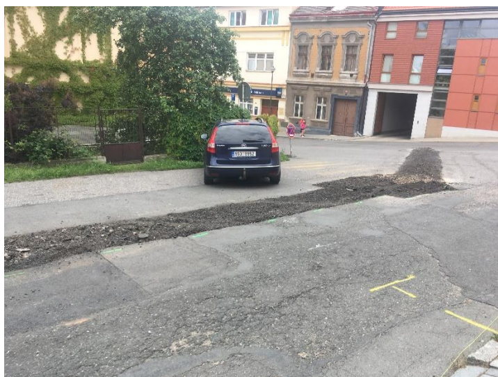
-provizorní úprava povrchu výkopové rýhy asfaltovým recyklátem
