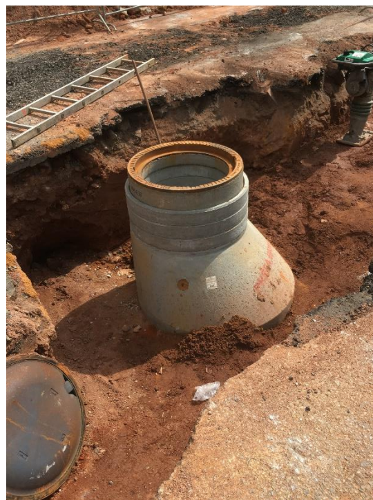
-zřízení nové kanalizační šachty
