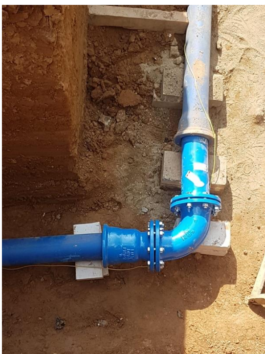
- lom vodovodního potrubí tvarovkou před dokončením, nainstalován signalizační vodič
