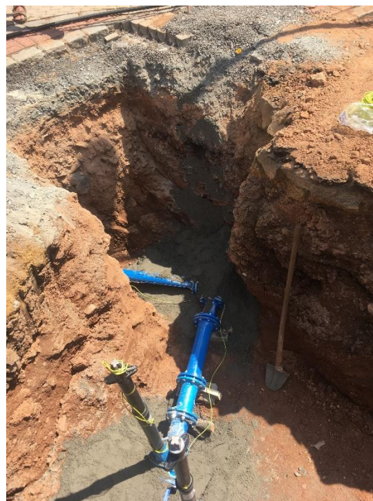
-vyskládání vodovodní trasy z tvarovek
