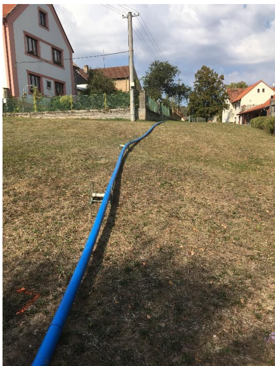
- položen provizorní vodovod na terénu
