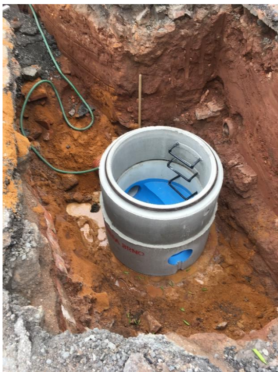
-založení kanalizační šachty
