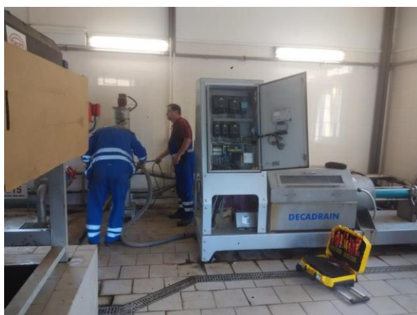
-demontáž původního zařízení
