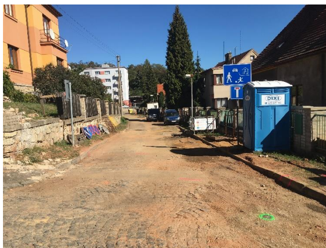
-provizorní zásyp a povrch výkopové rýhy bude nahrazen další koordinovanou stavbou rekonstrukcí povrchů ulice, kterou nechá provést Město Rakovník
