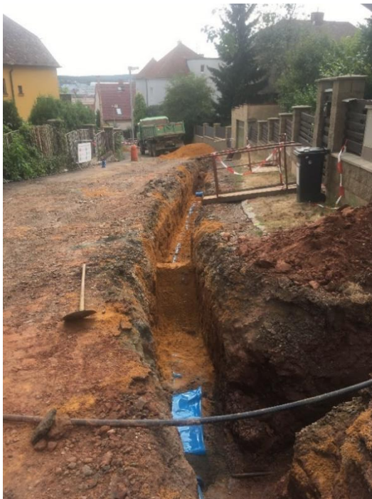
-zásyp výkopové rýhy s položením výstražné fólie
