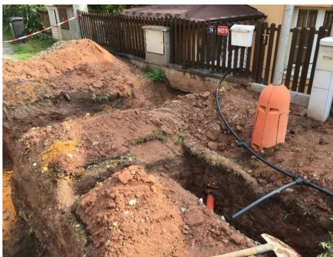
-výkopy pro vodovodní přípojky, položen provizorní vodovod po povrchu
