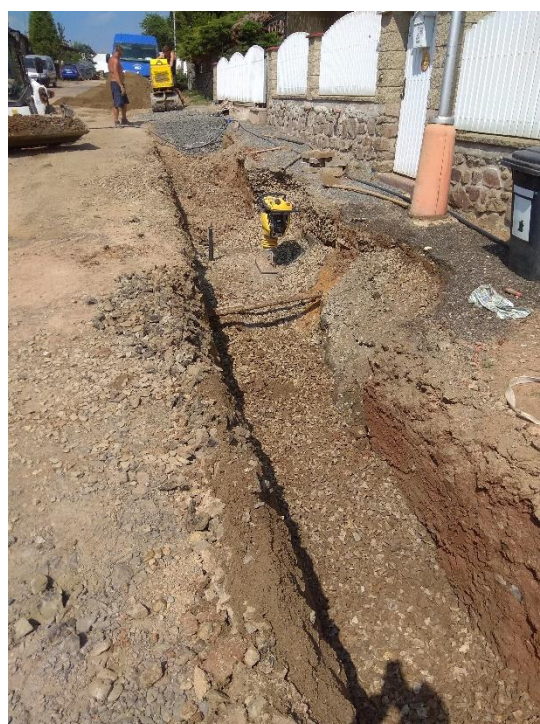
- provizorní zásyp výkopové rýhy bude nahrazen další koordinovanou stavbou-rekonstrukcí povrchů ulice, která poběží v režii Města Rakovník
