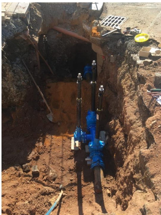
-armaturní uzel s umístění třech sekčních šoupat
