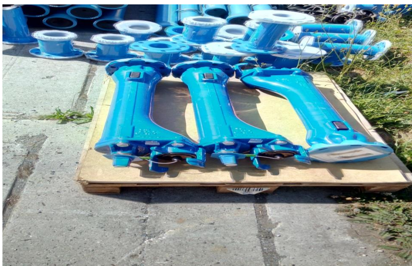
- armatury připravené k instalaci do rozvodné sítě: podzemní hydranty a přírubové přechodové kusy
