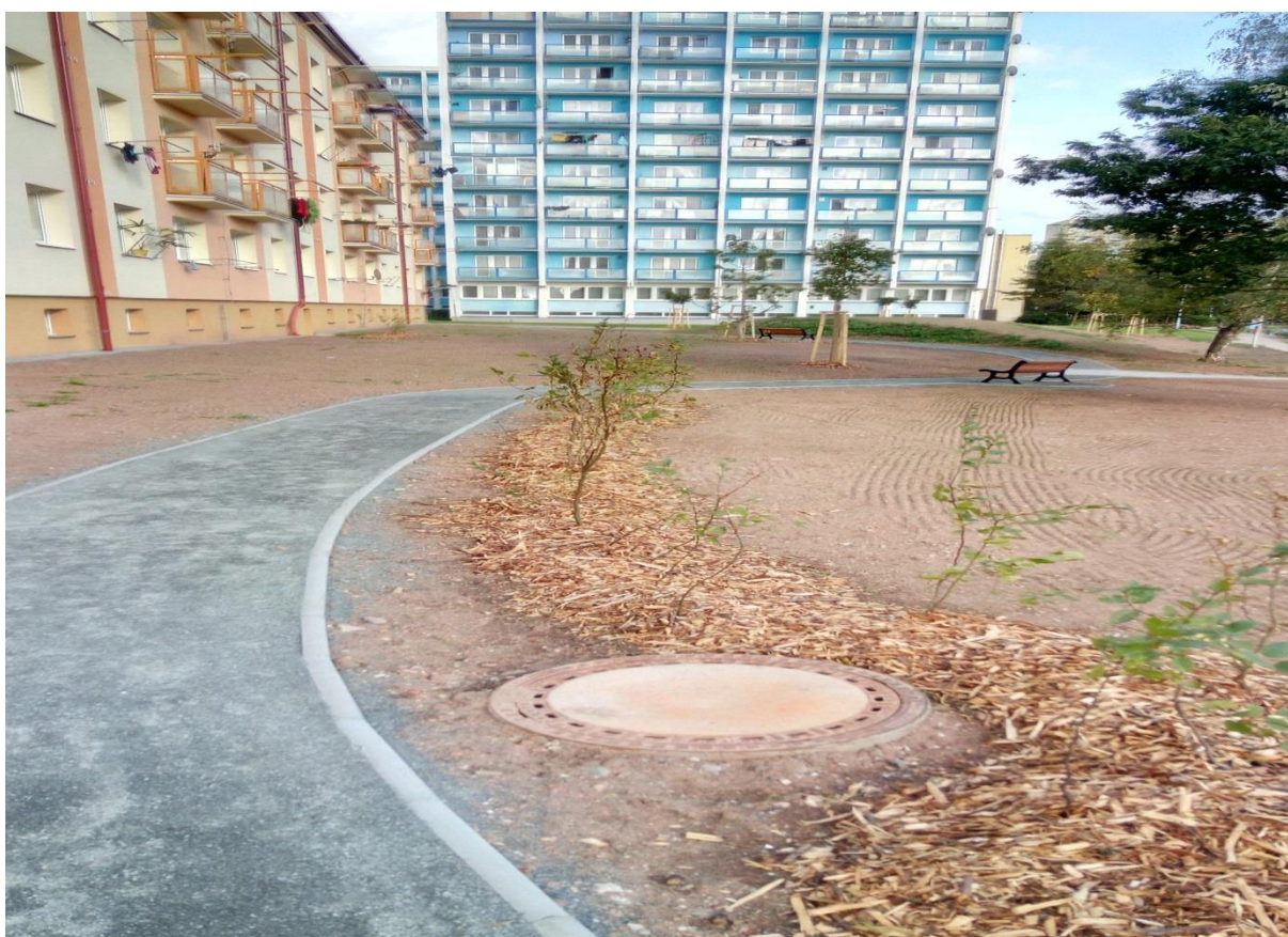
-konečná podoba sídlištního vnitro-bloku, povrchové úpravy zainvestovalo Město Rakovník po dokončení obnovy všech inženýrských sítí
