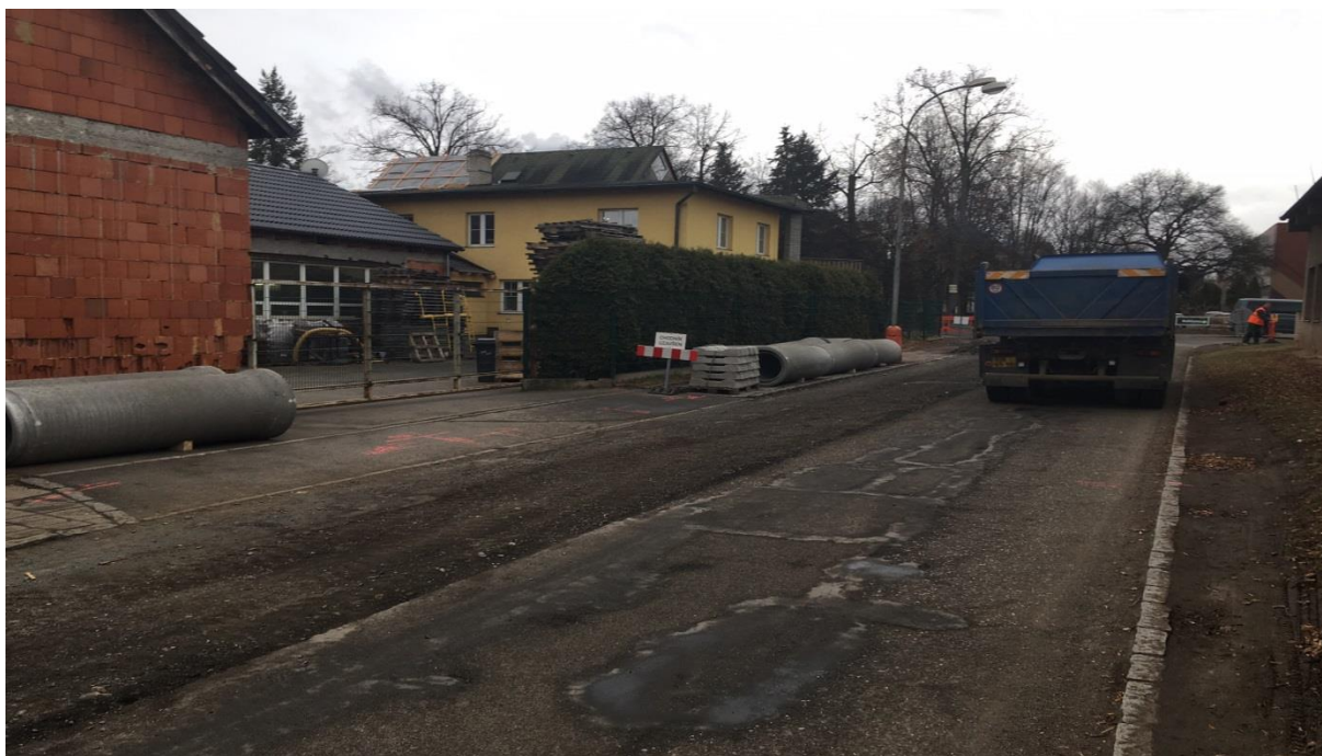
- ulice s vyfrézovaným pruhem původního asfaltového krytu před provedením otevřeného výkopu na výměnu kanalizačního potrubí, nové potrubí v provedení DN 600 betonové
