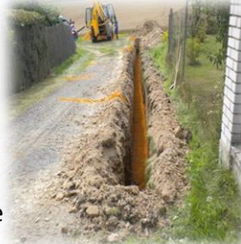
Kostelík obnova vodovodu
