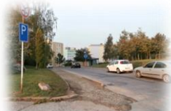
Přeložka vodovodu v Rakovníku v ulici V Jamce
