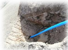
Týřovice obnova vodovodního přivaděče
