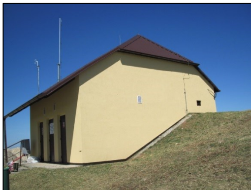
Zemní vodojem Pavlíkov
