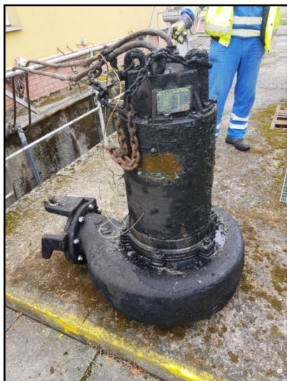
Obr. odpojení čerpadla
