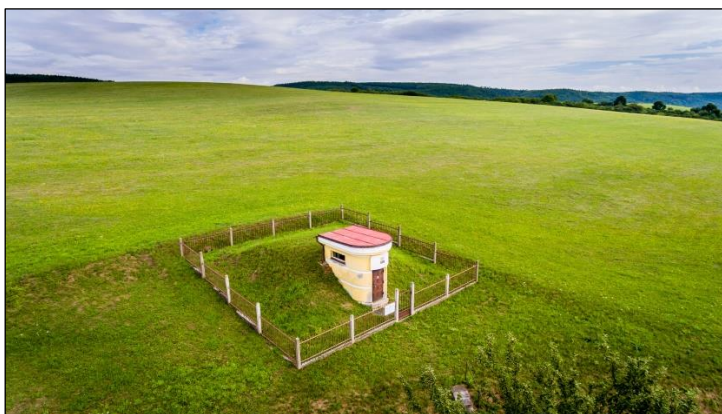
Zemní vodojem Týřovice
