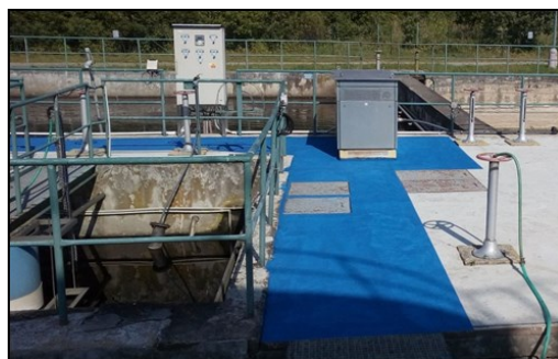
Aplikace bezpečnostního protiskluzového nátěru kolem technologické linky
