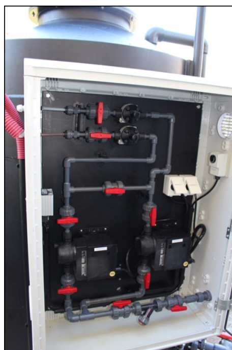
Instalace nádrže na \text{Fe}_2(\text{SO}_4)_3
