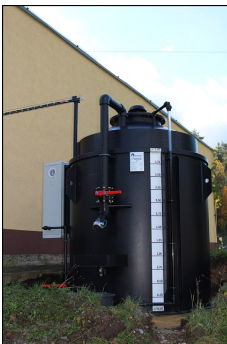
Instalace nádrže na \text{Fe}_2(\text{SO}_4)_3
