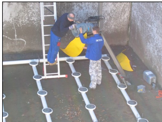
Výměna lopatek míchadla spojená s obnovou aeračních elementů
