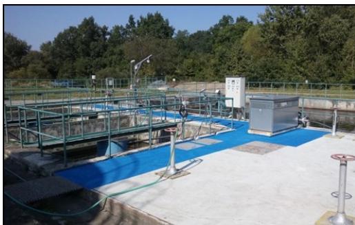
Aplikace bezpečnostního protiskluzového nátěru kolem technologické linky
