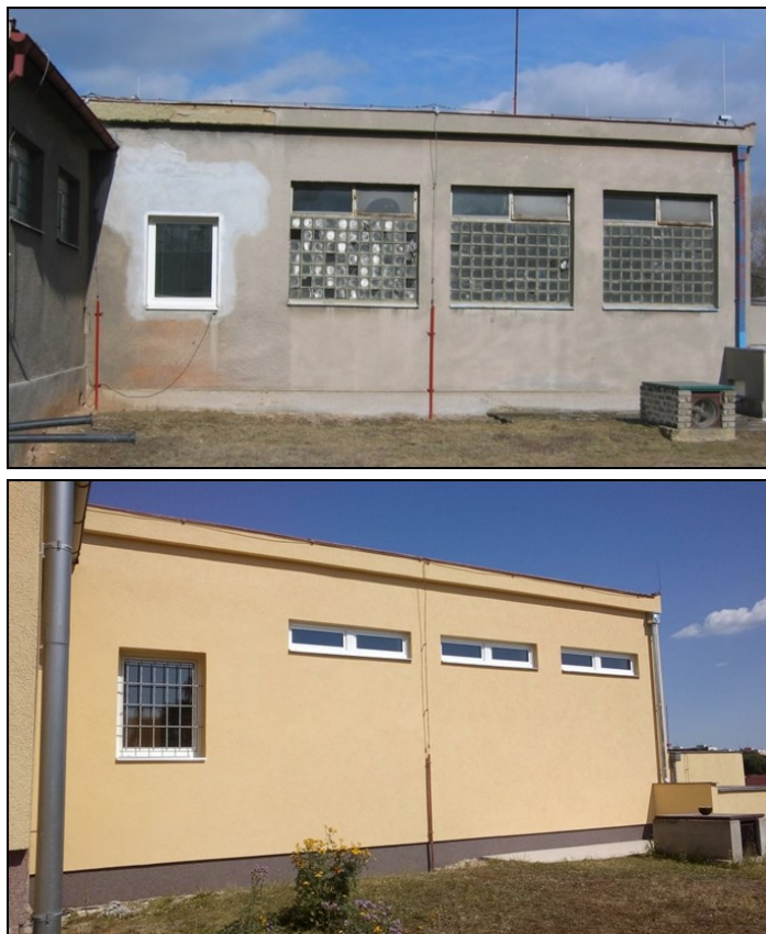
Oprava jižní části fasády hlavního objektu ÚV
