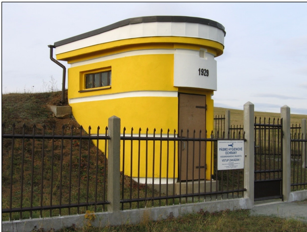
Zemní vodojem Týřovice
