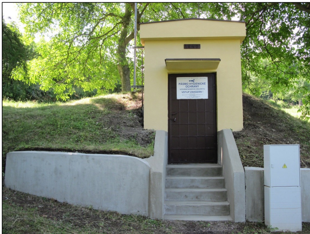
Zemní vodojem Kalivody
