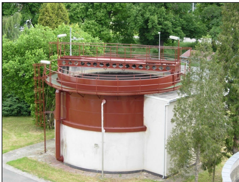
Zahušťovací nádrž na ČOV Rakovník
