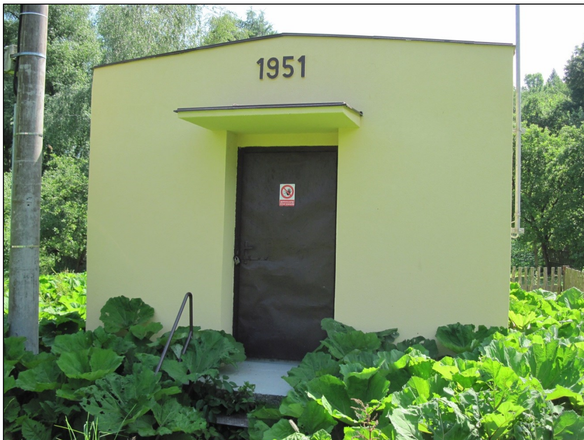
Čerpací stanice Kalivody
